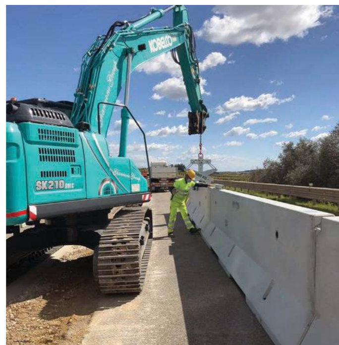
13. Il posizionamento della barriera NDBA spartitraffico
