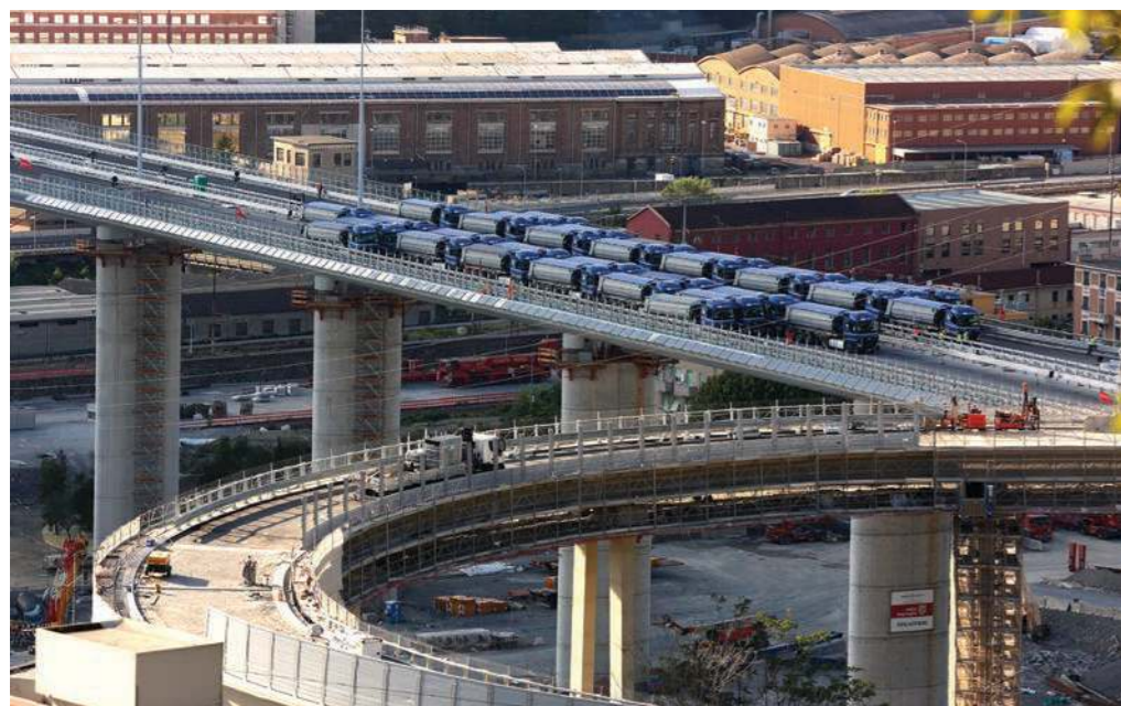
2. Una fase del collaudo statico del viadotto
