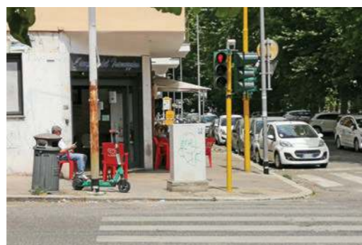
7A e 7B. Un impianto semaforico che, a causa dell'errato posizionamento dei pali di sostegno e della centralina, riduce notevolmente lo spazio per l'attraversamento dei pedoni
