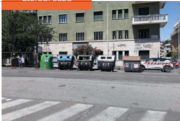
5. L'errato posizionamento dei cassonetti, che invece di essere posti al bordo del marciapiede, sono utilizzati per delimitare un cantiere stradale che è anche mal segnalato
