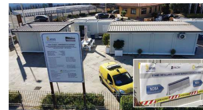
4. Il campo base della Valori Scarl per i lavori di adeguamento delle barriere della Tangenziale di Catania
