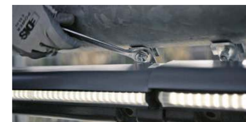
5. Un particolare del fissaggio del G-light-barriera
