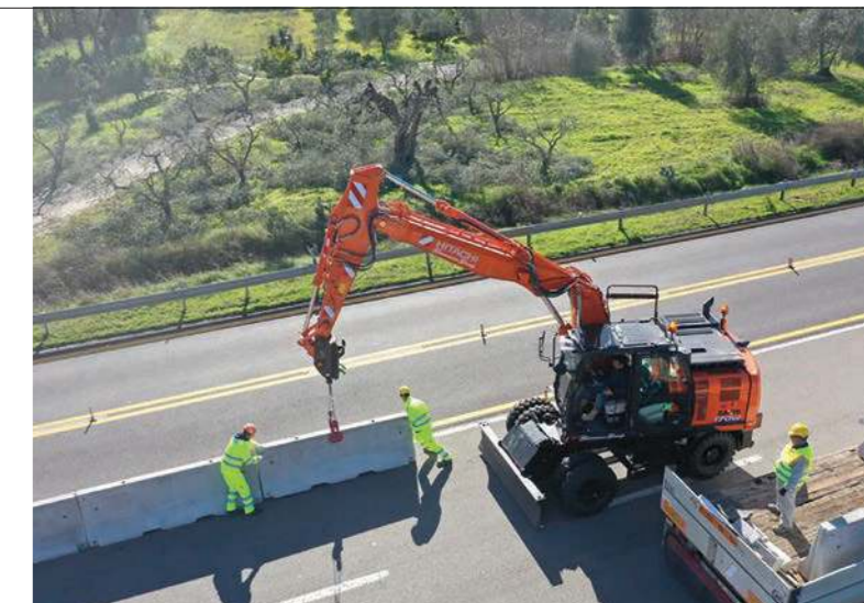
9. La posa in opera di barriere NDBA spartitraffico
