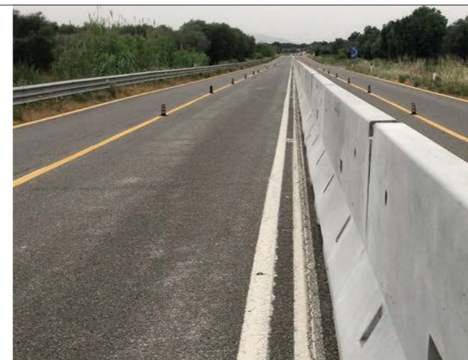
8. Le barriere NDBA spartitraffico installate dalla Valori Scarl sulla S.S. 407 "Basentana"
