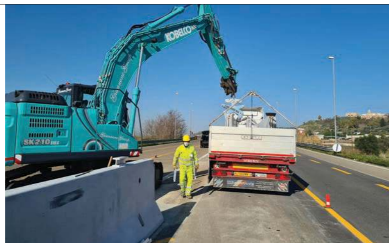
12. Lo scarico della barriera con escavatore dotato di idonea pinza
