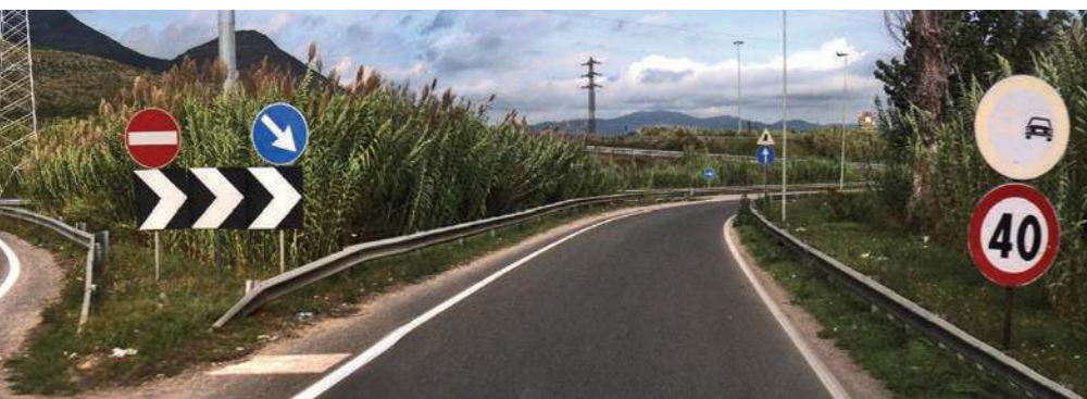
1. Un esempio di segnaletica non conforme e ridondante
