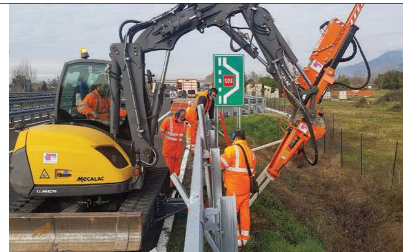
2. Una colonna battipalo modello 300A sul cantiere autostradale Pisa-La Spezia
