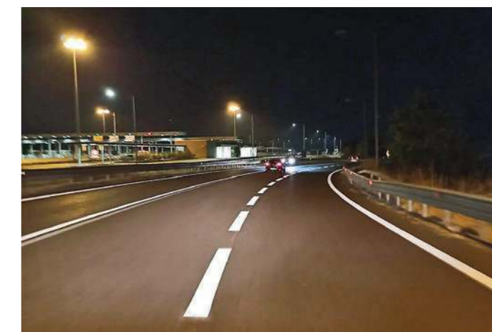
3. Una corretta progettazione ed esecuzione della segnaletica orizzontale sono fondamentali ai fini della sicurezza stradale
