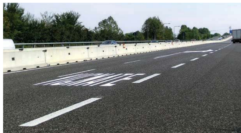
1. L'intervento ha interessato la S.P. 14 e la S.P. 103 (nella foto)
