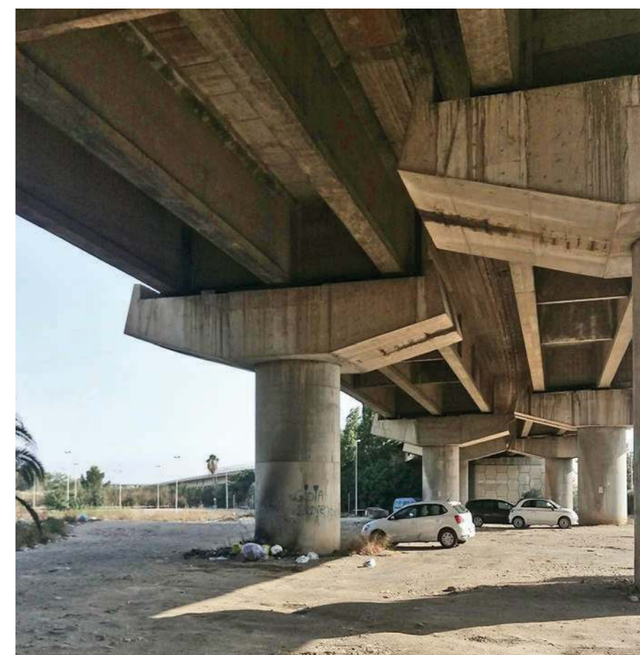
3. La costruzione di reti di trasporto, avulsa da una generale considerazione sul loro ruolo quale elemento centrale di trasformazione e ridisegno del territorio determina esternalità negative: spazi di risulta, margini e nuovi confini
