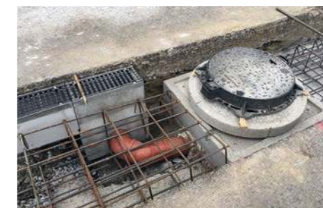
10. Un dettaglio dell'installazione della canaletta per la raccolta delle acque
